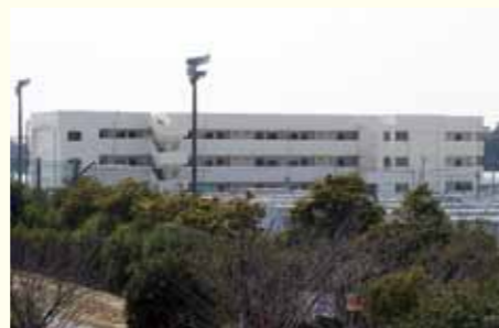
建設の進む復興住宅
