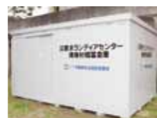
備蓄倉庫(匝瑳市)
