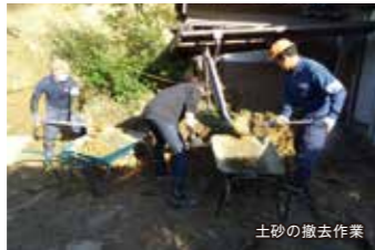
土砂の撤去作業
